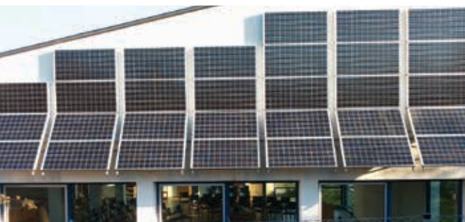
Photovoltaikanlage an der Südfassade der Philippuskirche. Foto: Heinrich Kilian
